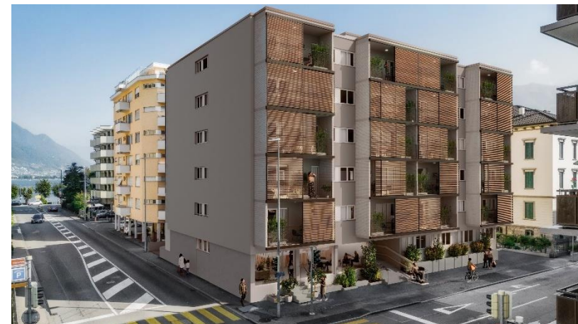
Rendu après la rénovation
